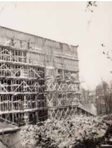
A MÉMOSZ-székház építkezése. Az irodaszárny udvari homlokzata, a háttérben a Regnum kupolája
